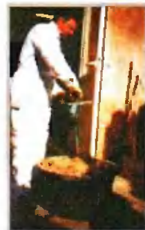
Приготовление небольшого объема рабочего раствора с помощью дрели с насадкой
