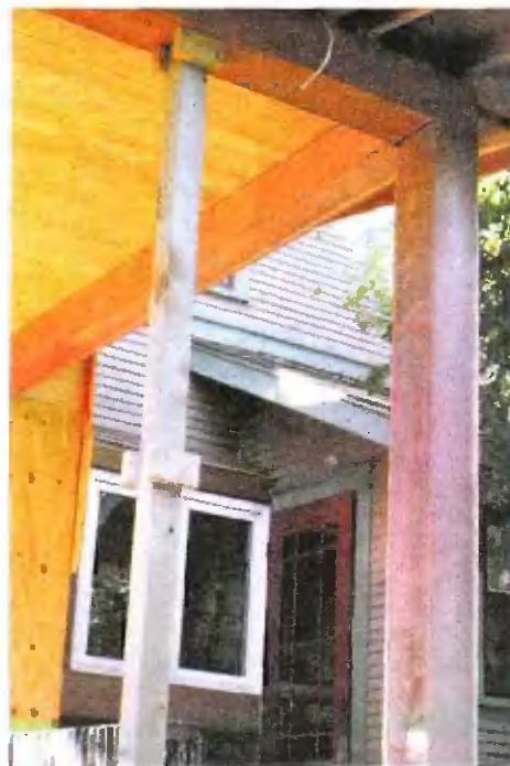
Стойки обшиты досками так же, как и переднее крыльцо
