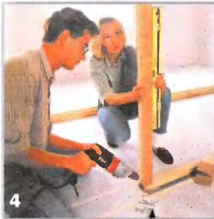
4 При креплении промежуточных стоек их положение следует постоянно проверять уровнем
