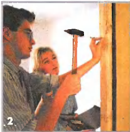
2 Через отверстия в бруске в отверстие стены забивают гвоздевые дюбели
