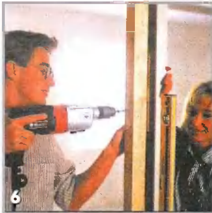
6 Шурупы большой длины, ввертываемые через промежуточные стойки во вставленные в профили рейки, будут надежно держать дверную коробку
