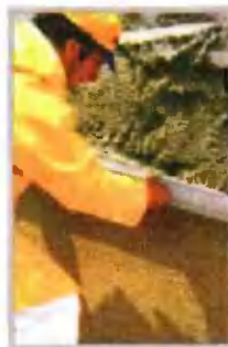
Выравнивание теплоизолирующей штукатурки правилом
