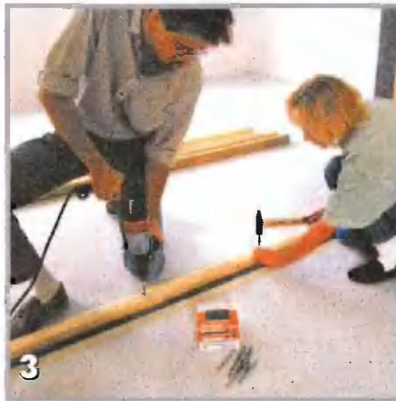
3 Отверстия в бетонном полу делают перфоратором. При рассверливании брусков ударный механизм электродрели отключают
