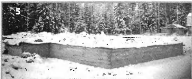
Через два дня после заливки бетона полиэтилен сняли и разобрали опалубку. Весной осмотрели фундамент — трещин и раковин не было
